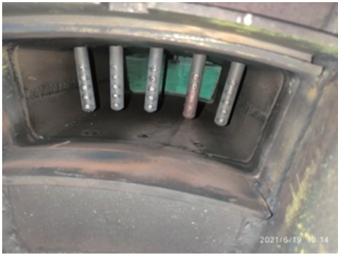
图 6 截面 G 5×5 热电偶阵 Fig.6 5×5 thermocouple array on section G
