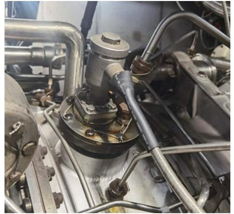
图 23 电涡流位移传感器实际图
